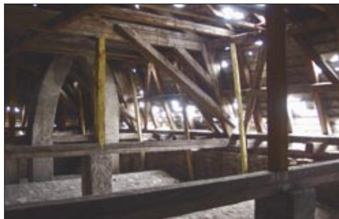
5/8 kép A Kaszárnya épület tetőszerkezete
