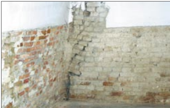
5/2 kép A falazat statikai hibája
